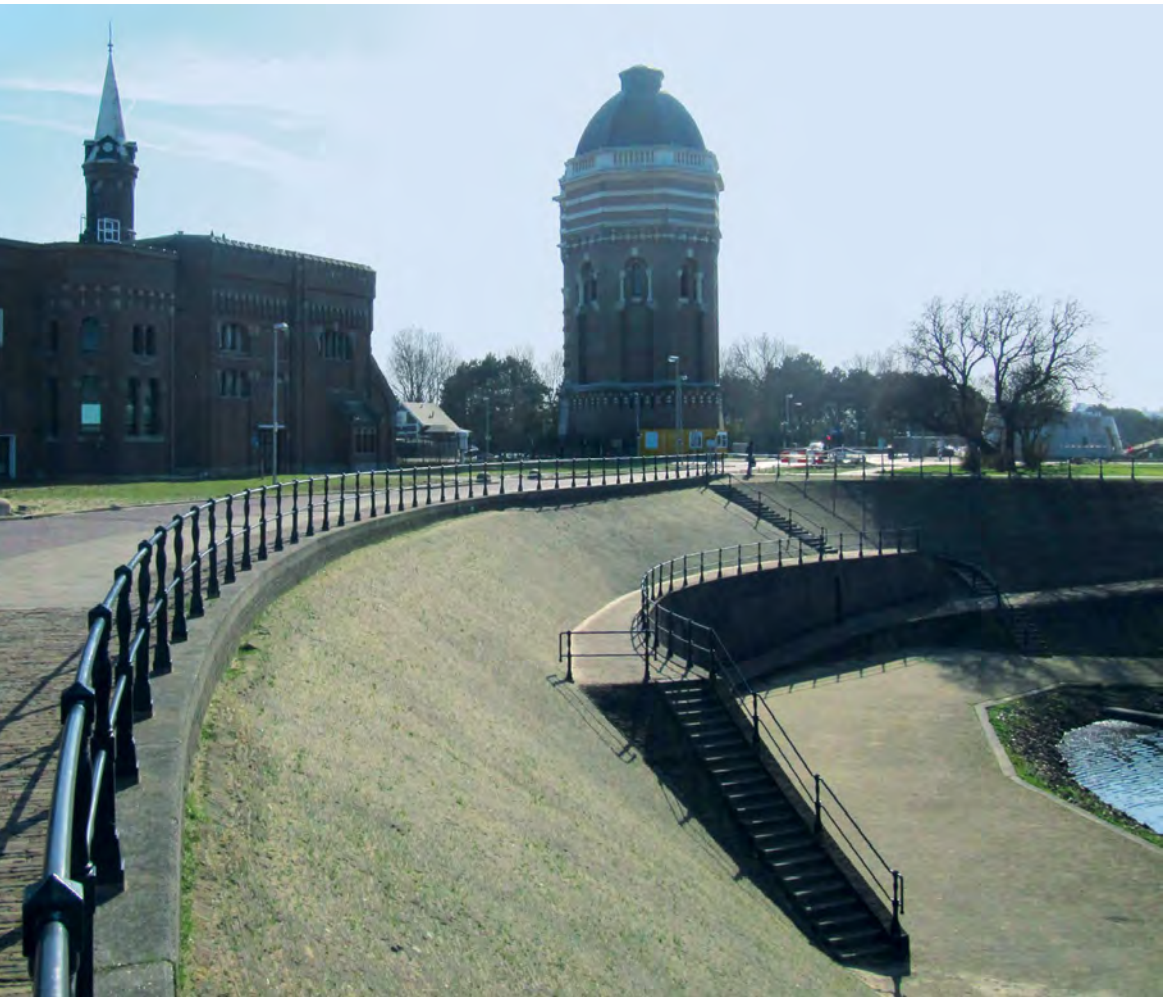
WATERverzamelkom en watertoren in Scheveningen.
